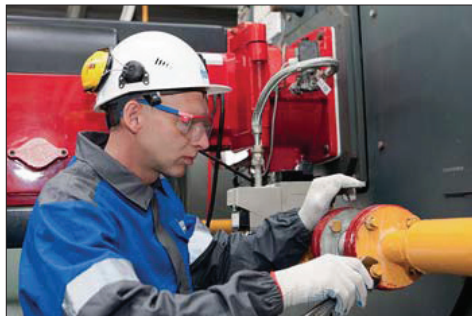
Протяжка запорной арматуры технологического оборудования
