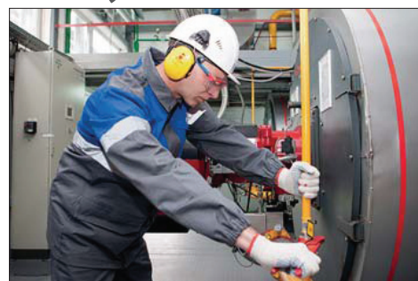
Замена запорной арматуры на технологическом трубопроводе
