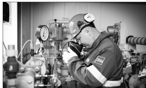
Проверка отсутствия загазованности газоанализатором.
