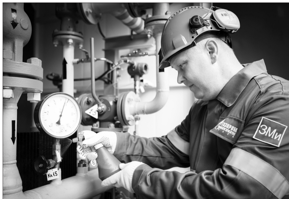
Проверка герметичности резьбовых соединений пенообразующим раствором.
