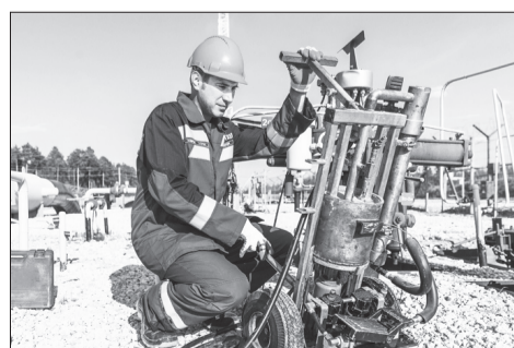
Набивка уплотнений крана.
