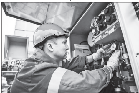
Технический осмотр средств и измерений блока управления крана.
