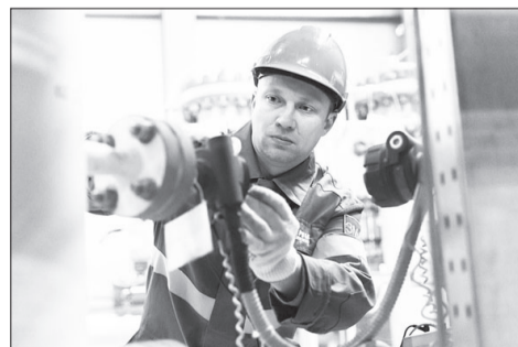
Техническое обслуживание и настройка датчиков уровня фильтров.
