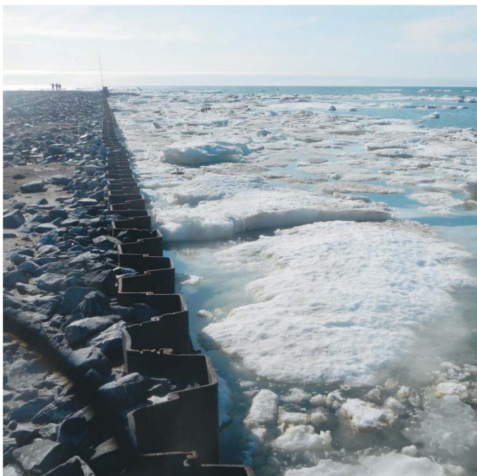
Защитный коффердам с ледяным припаем на входе газопровода в акваторию залива
