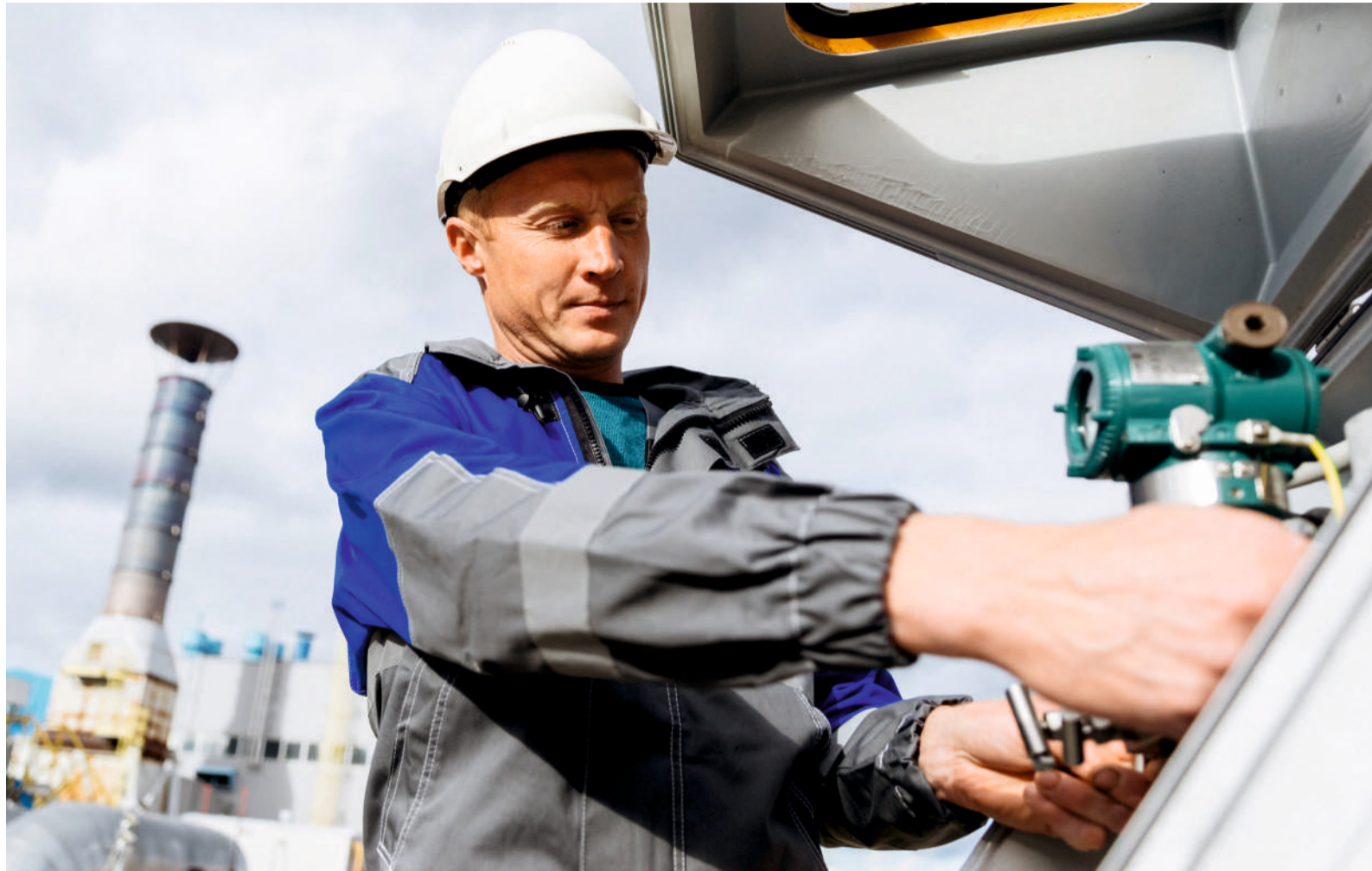
Василий Зуев, приборист 5 разряда КС «Новоурдомская» Урдомского ЛПУМГ, продвигает лини отбора датчика перепада давления газа
