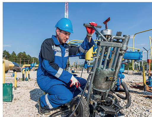
Набивка уплотнений крана
