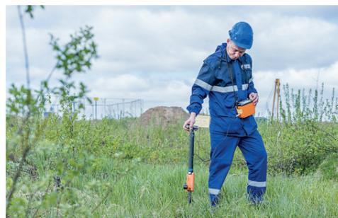
Поиск и обозначение трубы с помощью трассоискателя
