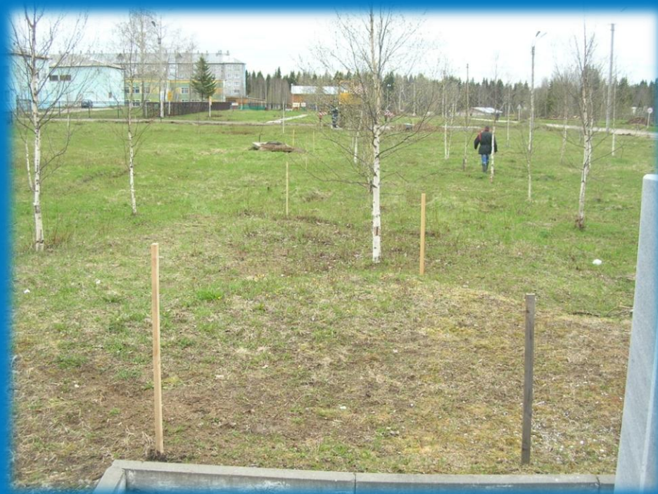
Фото 3. Разметка территории строительства
