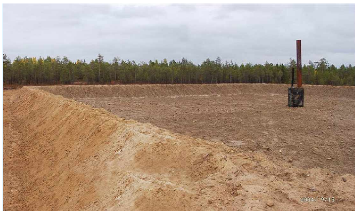
Техническая рекультивация амбара на 35 км конденсатопровода с применением методов биологической очистки
