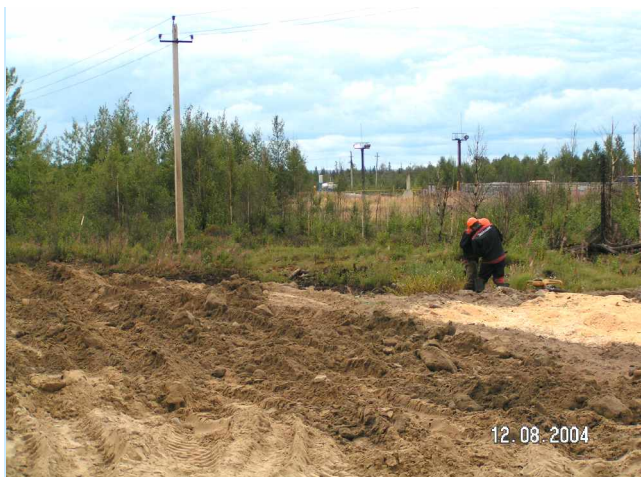
Внесение опилок в процессе рекультивации
