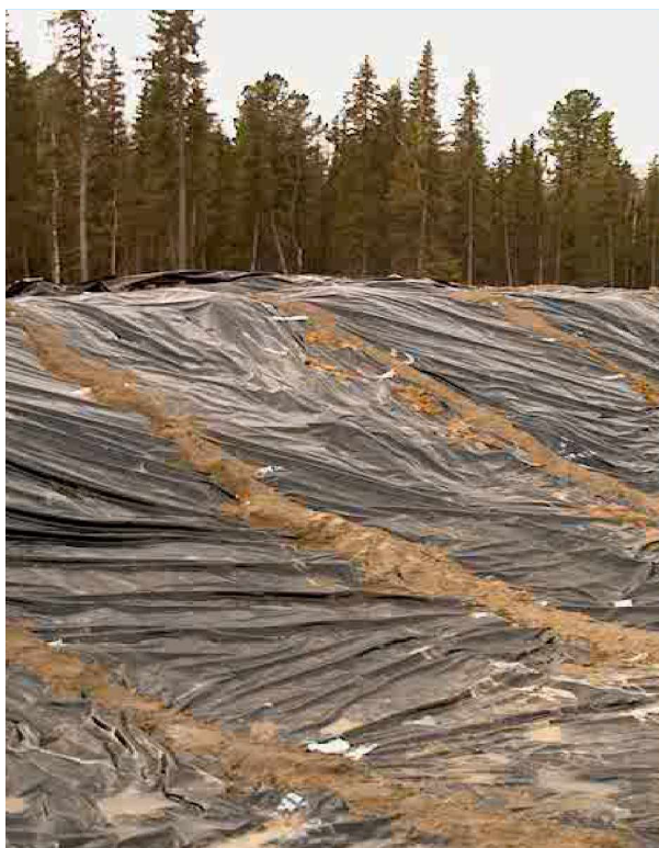
Строительство полигона для захоронения твердых бытовых и промышленных отходов (г. Вуктыл). Устройство гидроизоляции и планировка
