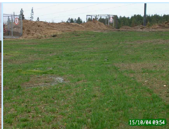
Результат работ через месяц по залужению территории вокруг амбара на 168 км
