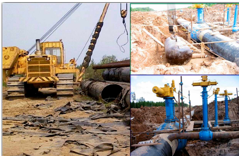
Реконструкция участков магистрального газопровода
