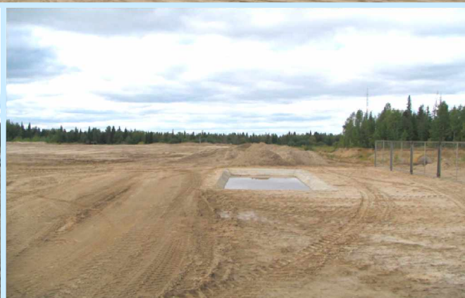
Предусмотрена бетонная ванна для дезинфекции ходовой части мусоровозов
