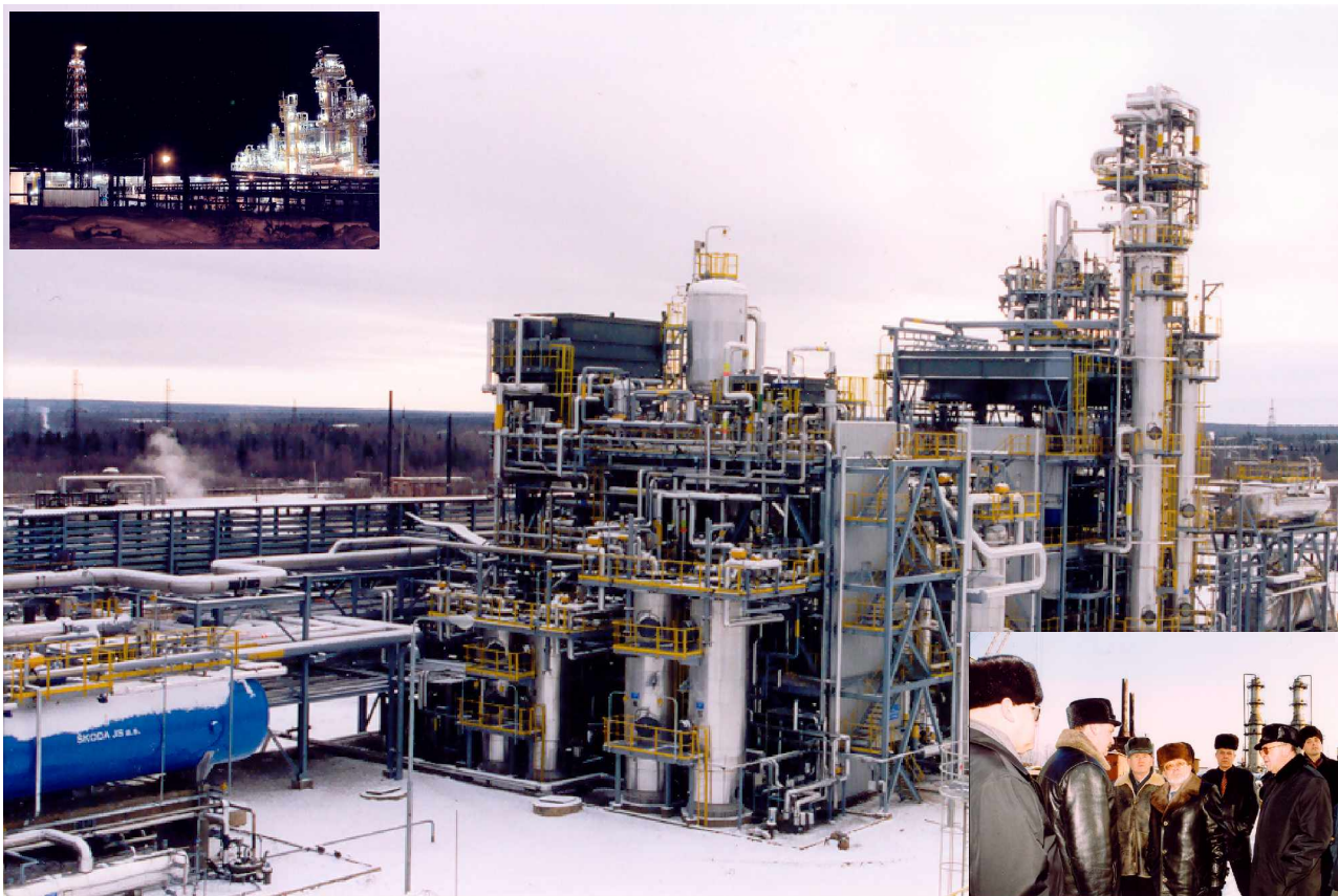
Цех 8 Сосногорского ГПЗ ООО «Севергазпром»
