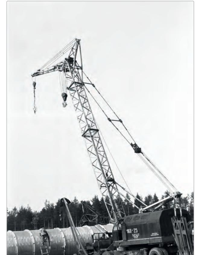
Строительство компрессорной станции № 10. Монтаж колонн системы воздухозабора. 1970 г.
