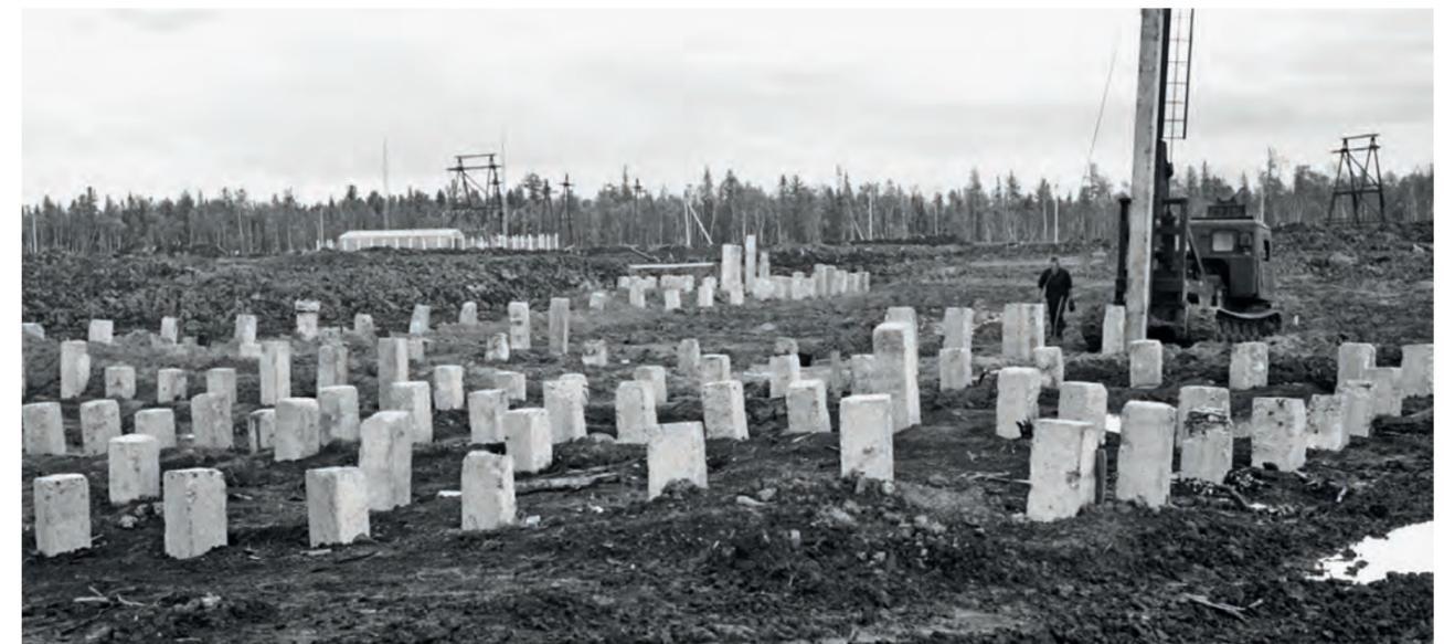
Вуктыл строится. Устройство фундаментов под пятиэтажный крупнопанельный дом.
