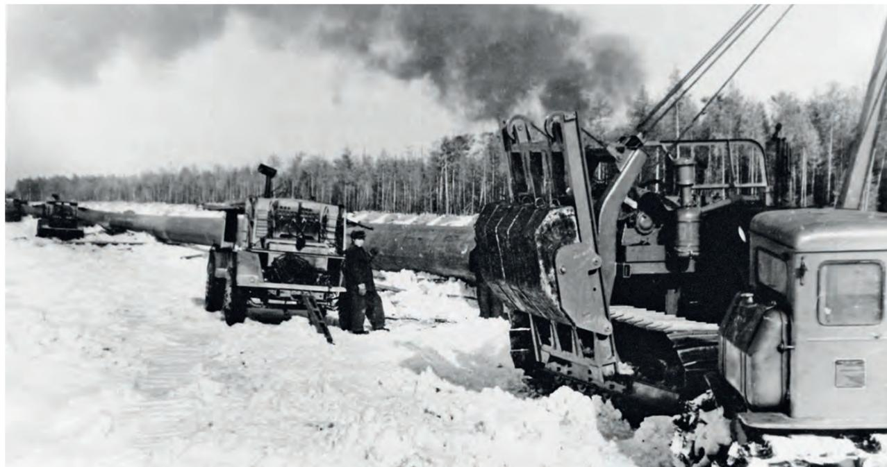
Ведутся изоляционные работы газопровода от головного сборного пункта № 3 (СП-3) до СП-5 Вуктыльского газового промысла. 1971 г.
