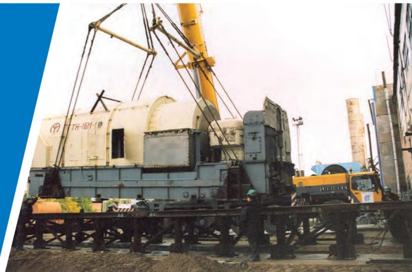
Подготовка газотурбинного агрегата для установки КС-10 Сосногорского ЛПУМГ. 1994 г.
