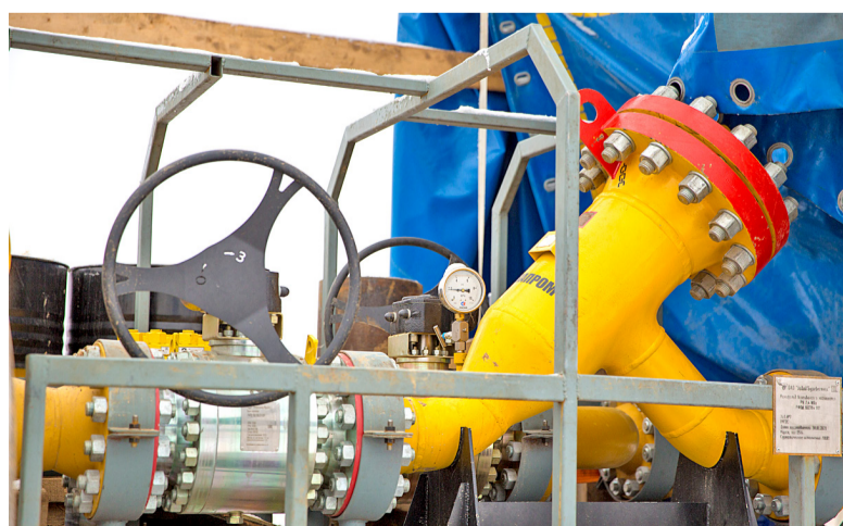
С помощью мобильной компрессорной станции перекачивается газ из одного газопровода в другой.
