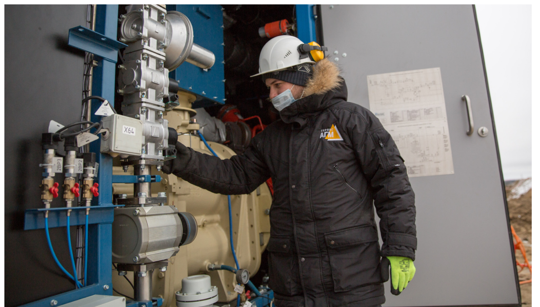
Первый пробный пуск азотной установки АГС-940
