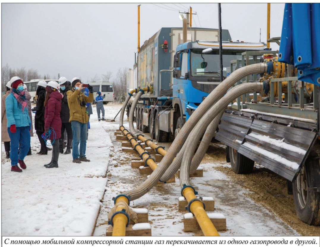
С помощью мобильной компрессорной станции газ перекачивается из одного газопровода в другой.
