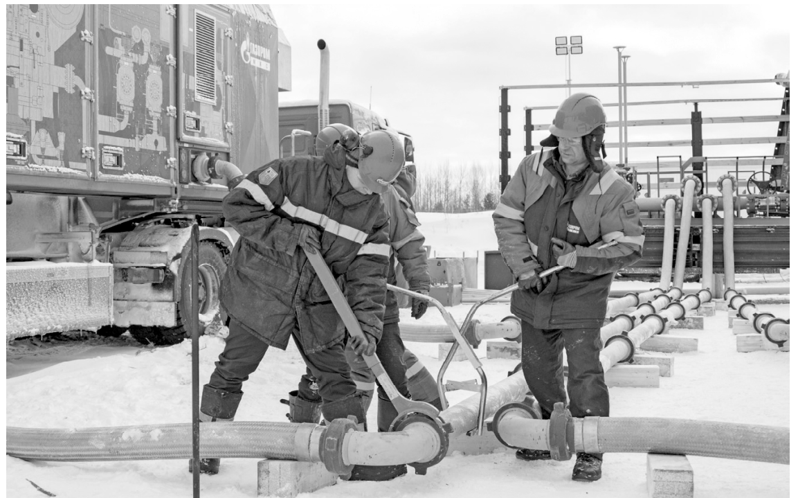
С помощью мобильных компрессорных станций газ из ремонтируемого участка газопровода перекачивается в параллельный газопровод.
