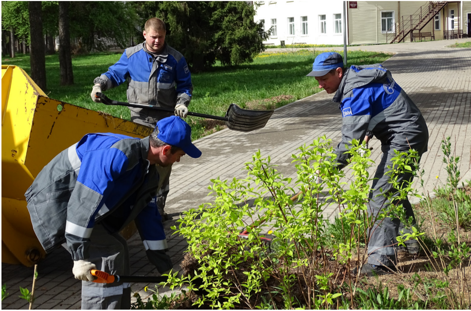
Сотрудники Нюксенского линейного производственного управления магистральных газопроводов ООО «Газпром трансгаз Ухта»
