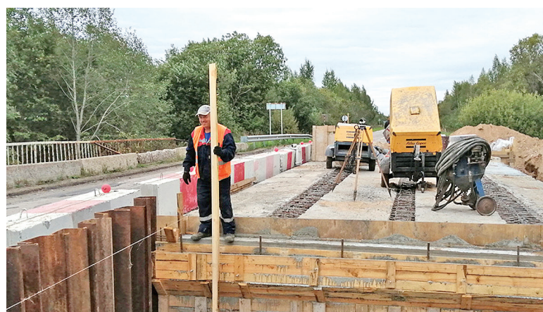
Мост хотя и невелик, но является важным объектом для близлежащих населенных пунктов и даже федеральной трассы М-8.
