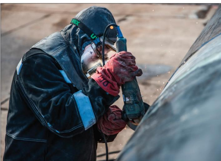
вание – костюм из кожаного спилка (куртка, штаны, подшлемник, краги). Сегодня ему предстоит сварка укрупненной заготовки в базовых условиях для предстоящего ремонта магистрального газопровода методом ручной дуговой сварки покрытыми электродами.
