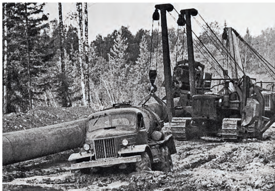
На строительстве газопровода «Сияние Севера», 1967–1969 гг.
