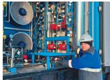
Шарытов Игорь Александрович, инженер участка эксплуатации и обслуживания АГНКС Нюкенского ЛПУМГ возит компрессорного отсека новой АГНКС
