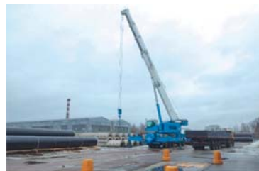
«Галичанин» на выполнении работ по погрузке, выгрузке, перестановке железобетонных изделий
