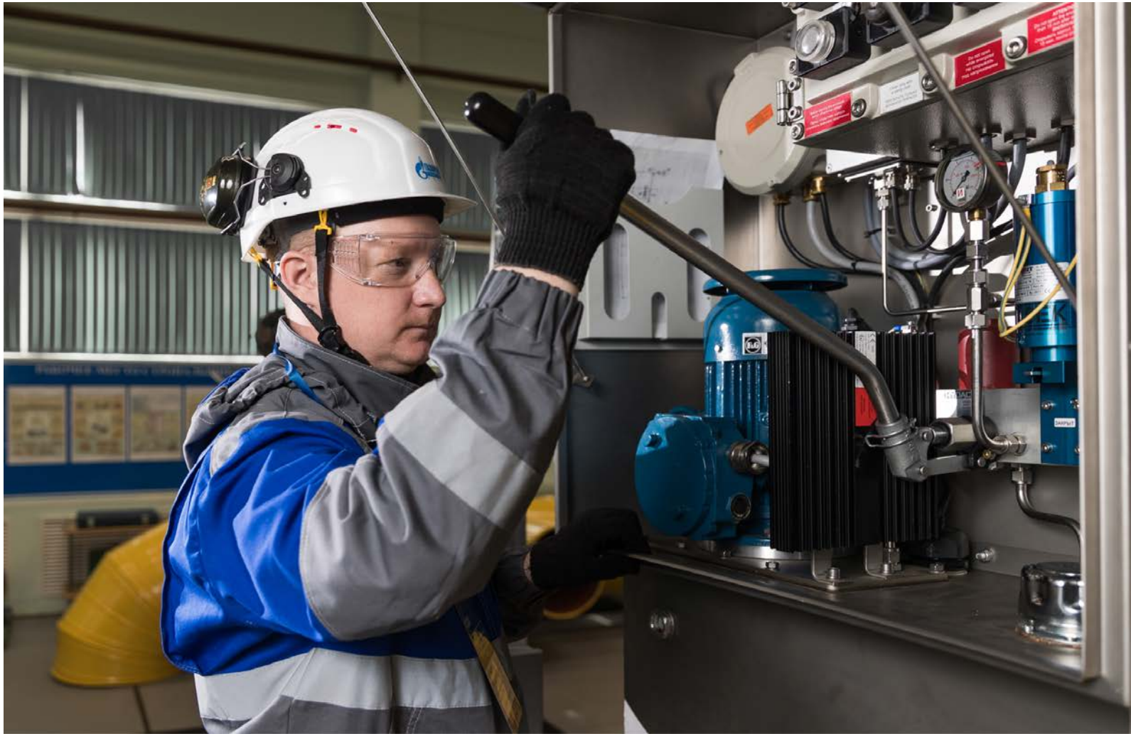
Евгений Юрьевич Калиновский – трубопроводчик линейный линейно-эксплуатационной службы Воркутинского ЛПУМГ
