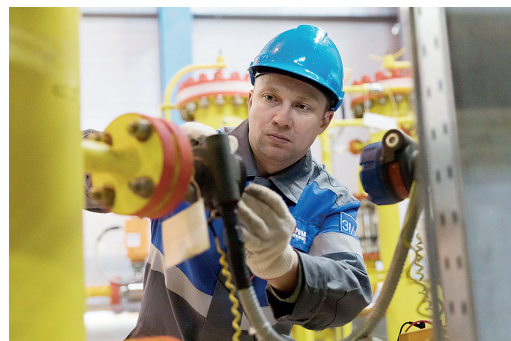
Техническое обслуживание и настройка датчиков уровня фильтров
