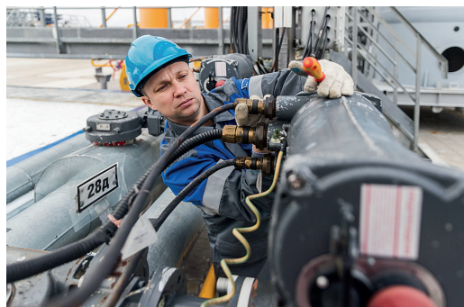
Обслуживание и настройка концевых выключателей крана
