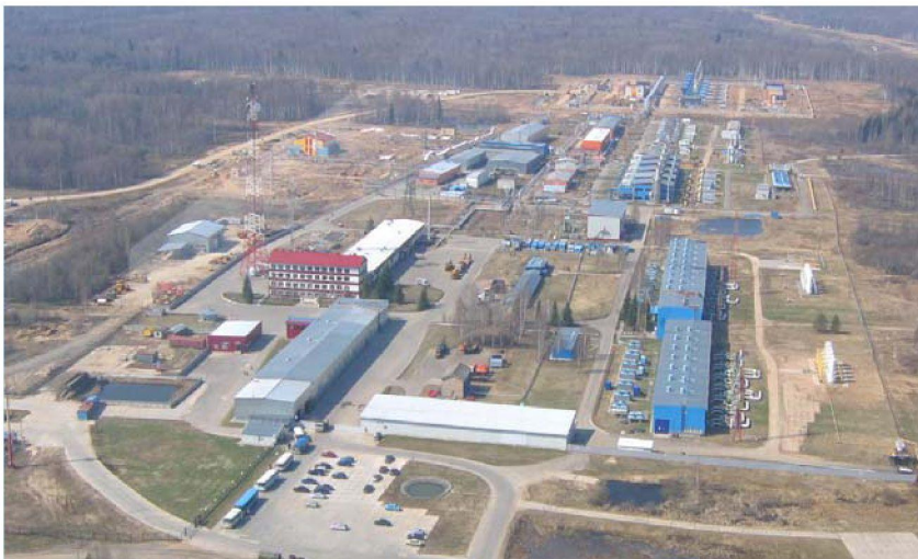
КС-18 Мышкинского ЛПУМГ
