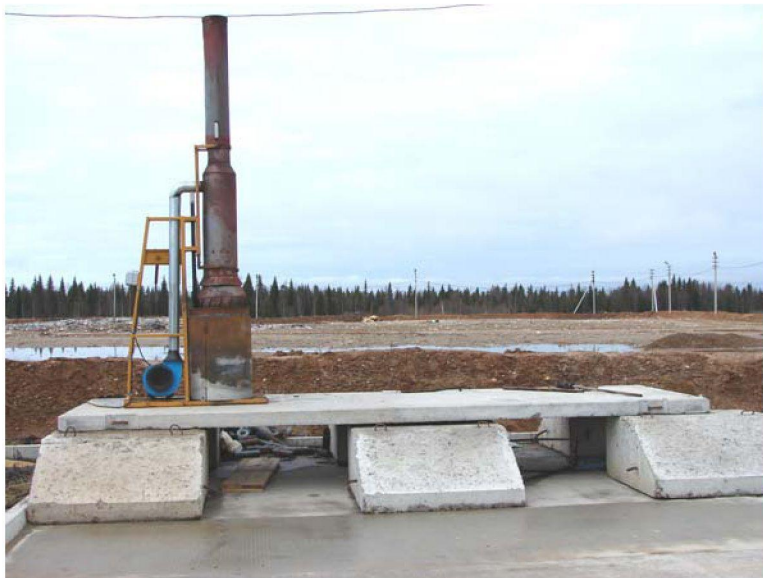
Установка по термической утилизации отходов «Факел», эксплуатируемая на полигоне Урдомского ЛПУМГ
