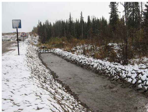
Фильтр отстойник на вдольтрассовом проезде МГ СРТО–Торжок
