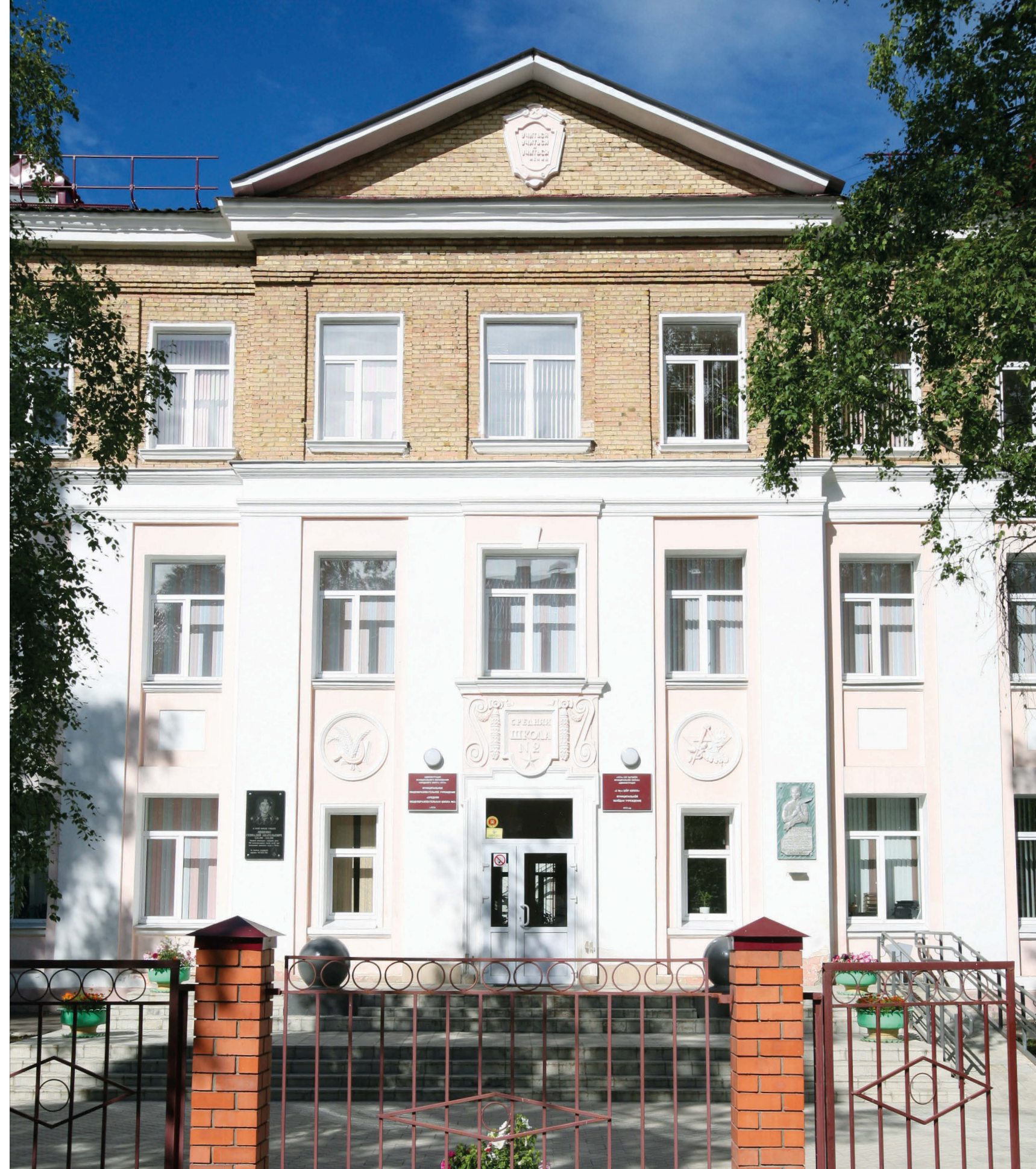
Средняя образовательная школа № 2, г. Ухта, капитальный ремонт — 2013–2015 гг., 46 млн рублей
